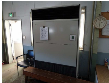
更衣室エアコン更新 2023年5月
