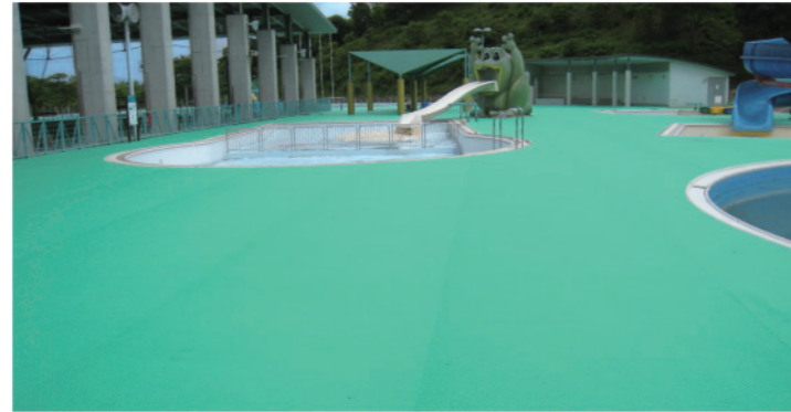
(施工後:BOC-07 ライトグリーン)
