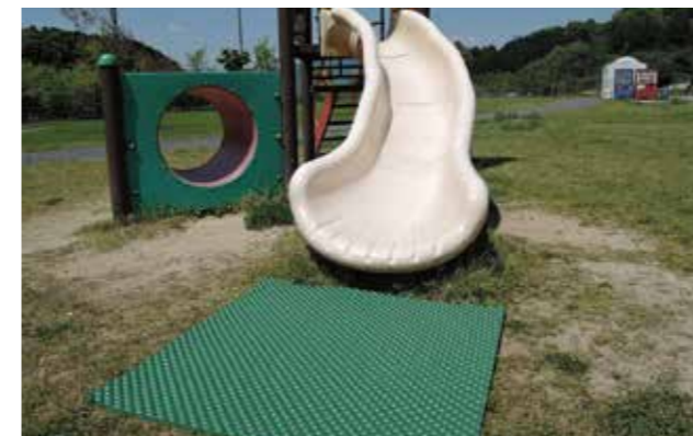
(施工後:BO-K グリーン)
