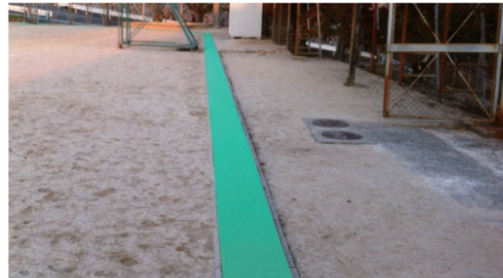
(施工後:BOC-07 ライトグリーン)
