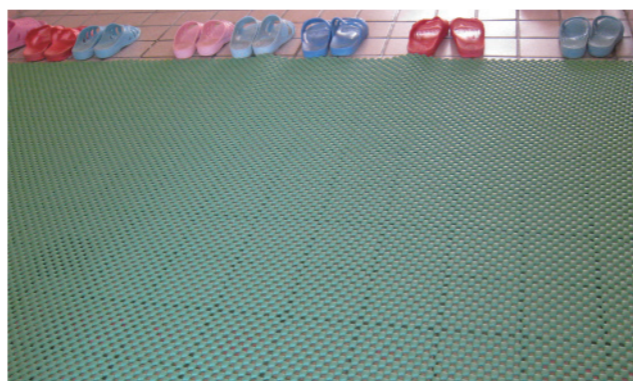
(施工後:BOC-05 グリーン)
